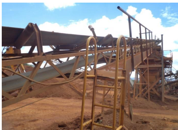
Antes – Passarela de acesso ao TR-01 (curta)
