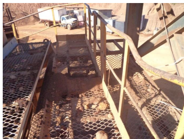
Depois – Passarelas sem acumulo de material.
