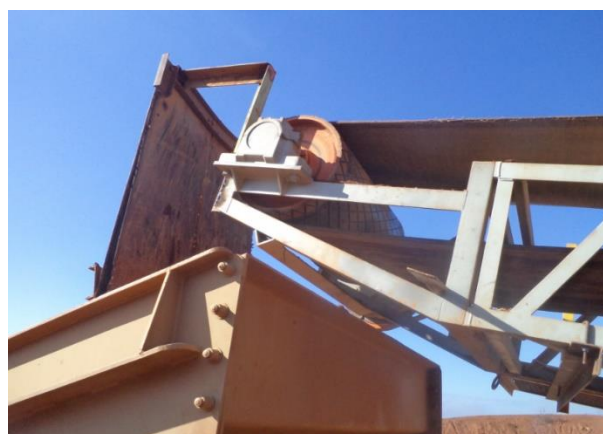
Depois – TR01 - Descarga de material na PN01
