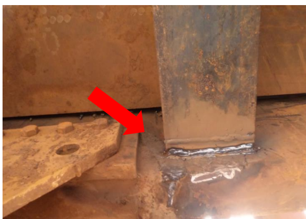
Depois – Solda e instalação de suportes.
