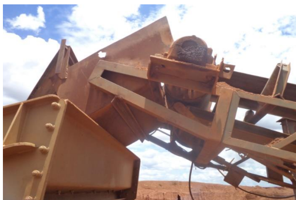
Antes – TR01 - Descarga de material na PN01
