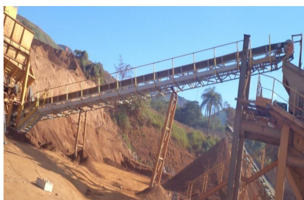
Depois – TR01 com nova estrutura e passarela completa.
