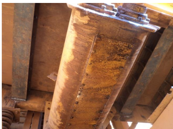
Depois – Instalação de suportes.
