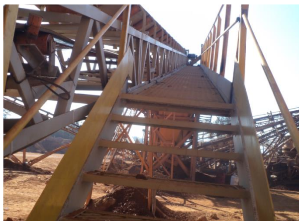
Depois – Nova estrutura do TR-01 (escada e passarela completa).
