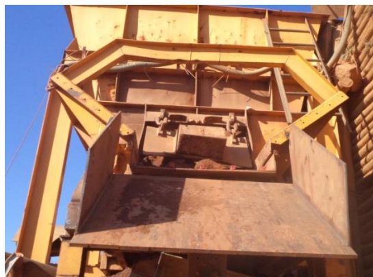
Depois – Bica de saída – Grelha
