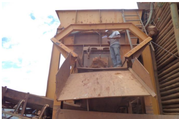
Antes – Bica de saída – Grelha
