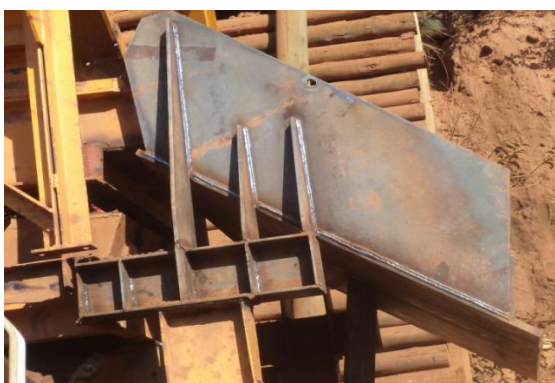
Reforma na base de sustentação e lat. Esq
