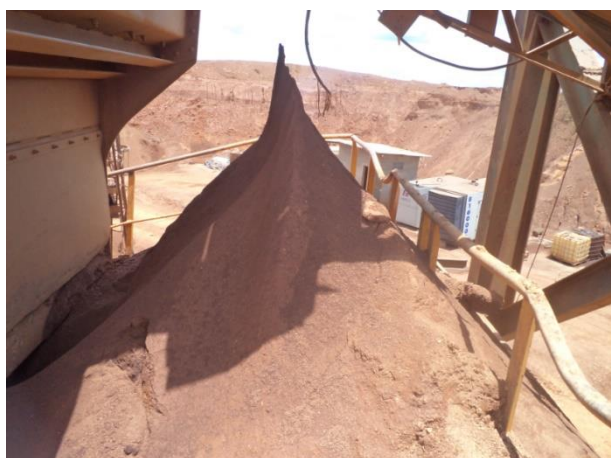
Antes – Acumulo de material na passarela da PN01.
